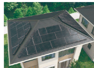
太陽光発電の設置
